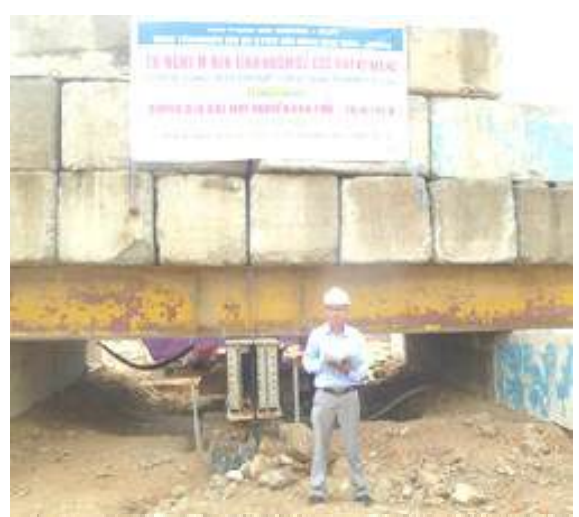
Nén tĩnh nhóm 7 cọc đất xi măng – Cầu Trần Thị Lý, Đà Nẵng
