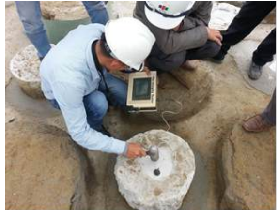
Thí nghiệm PIT cọc khoan nhồi – FPT complex
