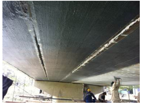
Thử tải và tư vấn sửa chữa và gia cường FRP - Cầu T.L, Đà Nẵng
