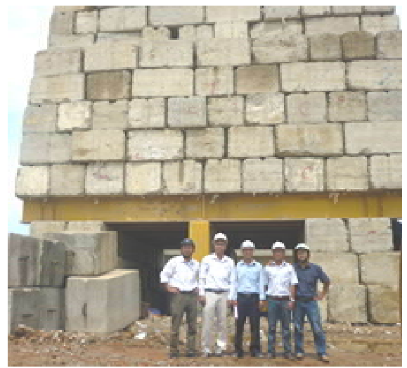
Nén tĩnh cọc khoan nhồi 2600T – Cầu Trần Thị Lý, Đà Nẵng
