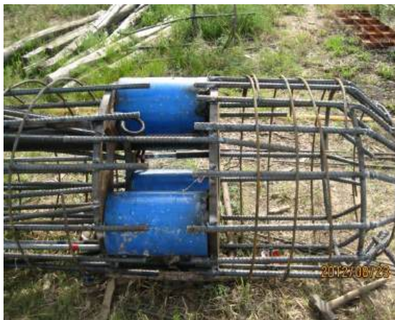
Lắp đặt và thí nghiệm O-cell – Seabank Đà Nẵng
