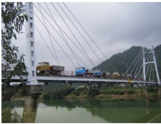
Thử tải và thiết kế sửa chữa cầu Phò Nam – Hòa Vang, Đà Nẵng
