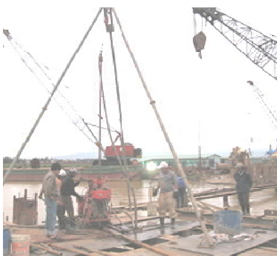
Khoan lấy lõi cọc khoan nhồi – Cầu Khuê Đông, Đà Nẵng
